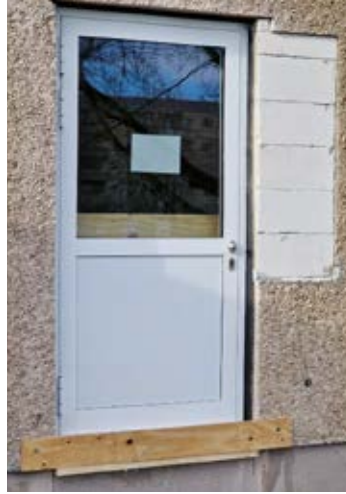
Im Bau: Neuer Notausgang
