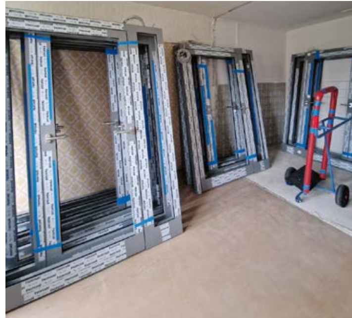
Einzubauende Brandschutztüren
