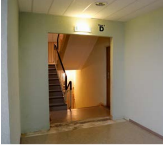
Hier trennen künftig Brandschutztüren Flure und Treppenhäuser.
