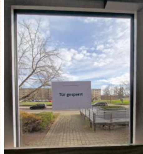
Während der Bauphase gesicherter neuer Notausgang
